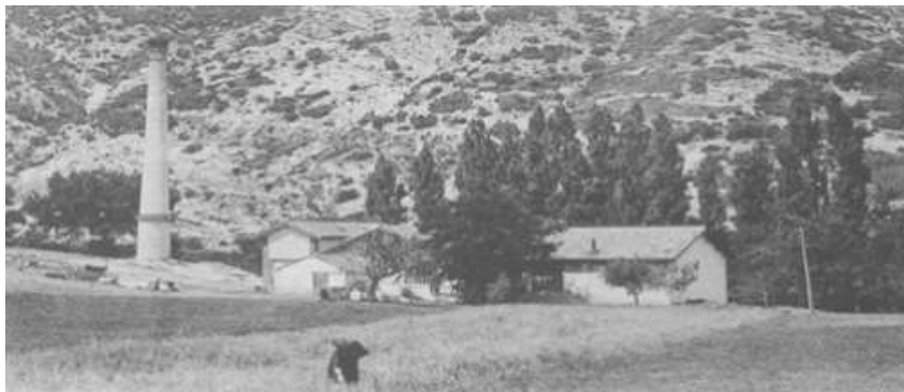
L'usine hydro-électrique de Béconne
