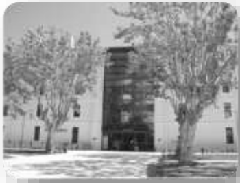
Entrée Saint Martin
