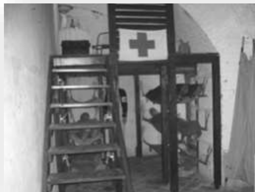
Infirmierie dans le Fort de Vaux
